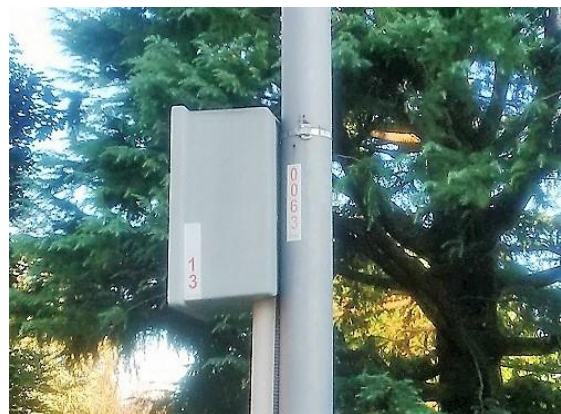
Quadro Enel Sole senza contatore.
